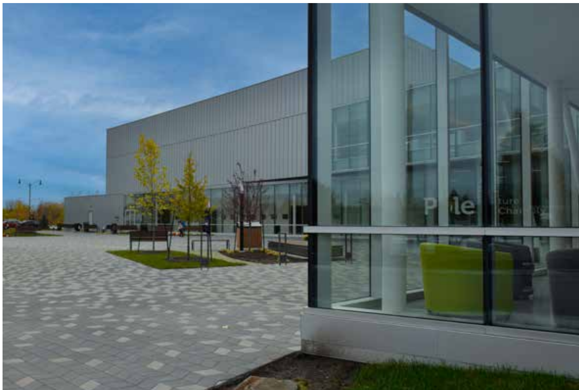
Project : Pôle Culturel de Chambly | Chambly, QC Architect : Jodoin Lamarre Pratte Architectes Profile & color : MS 1 | Metallic Grey
