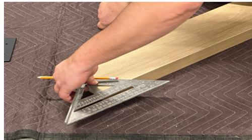
5.1.4 Une fois les mesures rapportées, procédez à la coupe du morceau n°2. Assurez-vous que les ajustements sont conformes, puis installez la braquette de fixation.
