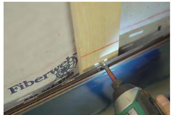
Advenant le cas où une fourrure n'est pas alignée, nous recommandons de laisser un jeu entre le mur ou la fourrure et le parement d'acier lorsque la vis y est fixée dans le but d'éviter de créer une trop grande tension sur le produit, ce qui pourrait entraîner un effet de voilement.
