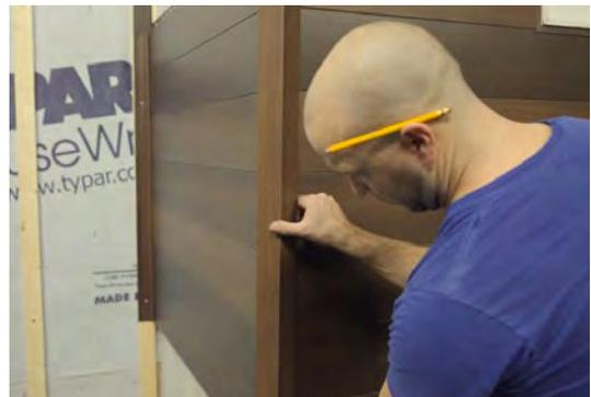
\*À défaut d'avoir un appui, vous devrez fixer le coin à l'aide d'une vis. Taillez et repliez le bas de la moulure de finition de façon à créer une surface de fixation.
